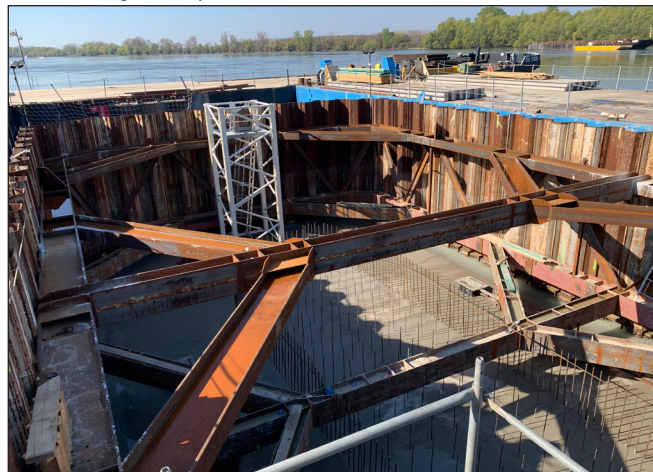
2. ábra: P5 j. mederpillér őrfal kialakítása
