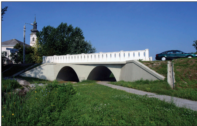
1. ábra: A solti vasbeton boltozatú csatorna híd
