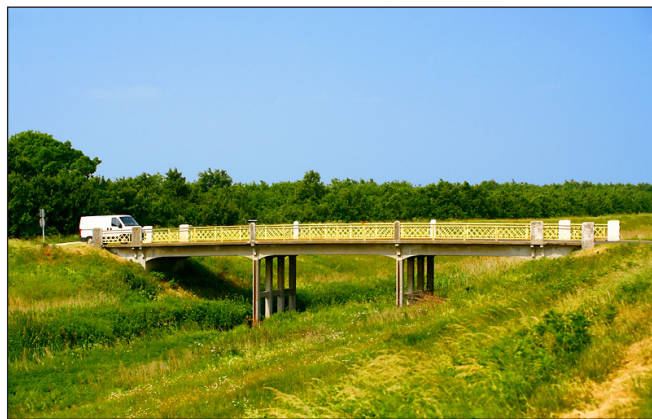
4. ábra: Rábakecöl Répce-árapasztócsatorna hídja
