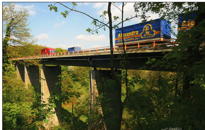
9. ábra: A Bolondúti völgyhíd
