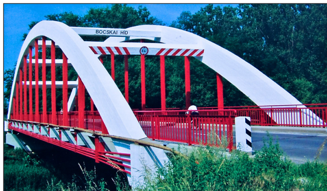
10. ábra: A tiszalöki Keleti-főcsatorna-híd
