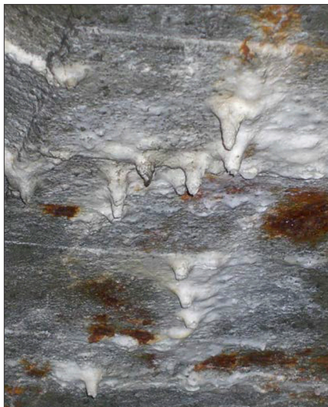
5. ábra: Savas esővíz hatására a vasbetonlemezről kioldódott, cseppkőszerű karbonátok (Fénykép: Kausay)
