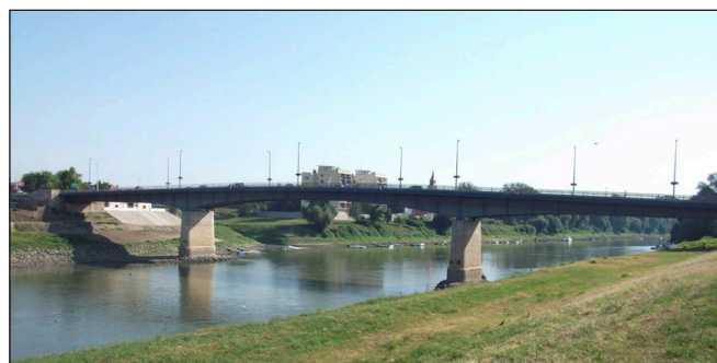
5. ábra: A szolnoki Tisza-híd
