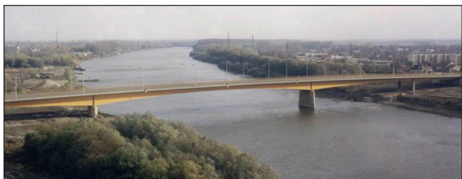
8. ábra: A szegedi Bertalan Lajos Tisza-híd
