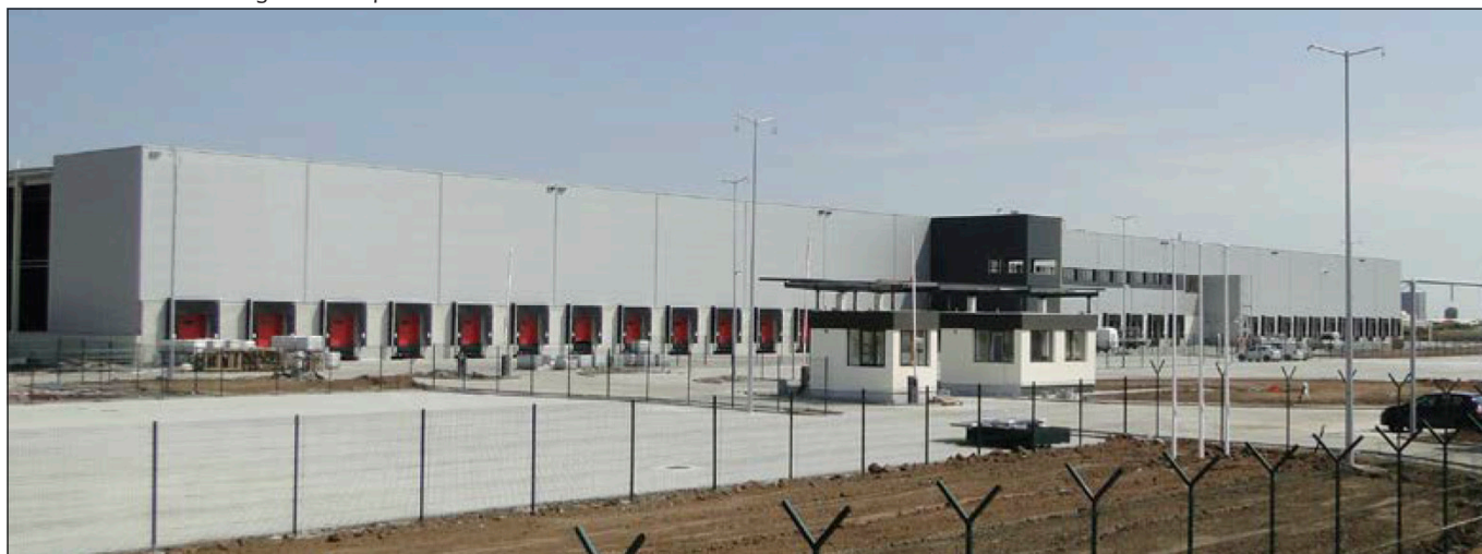
20. ábra: Az elkészült logisztikai központ főhomlokzata
