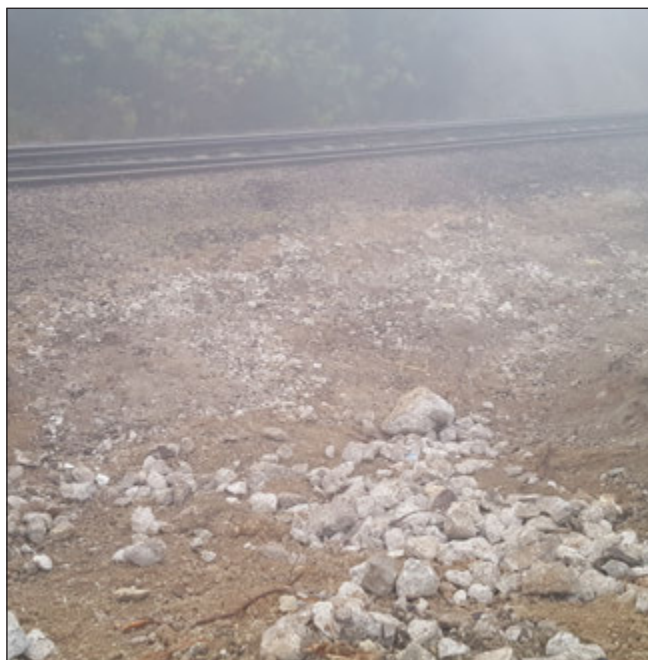
10. ábra: Az elbontott híd helye
