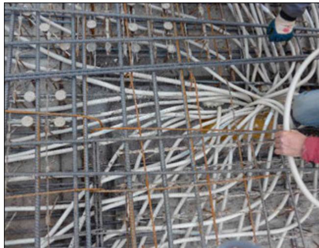
9. ábra: A földélemezbe elhelyezett kábelek (Polónyi, 2007) (fotó: Brandmaier)
