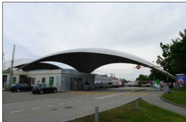
7. ábra: Bubble shell: Deitinger Süd Rasstätte. 1968, Heinz Isler (fotó: Genzel)
