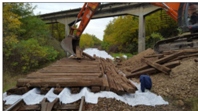
6. ábra: A nagyvasúti pálya letakarása a híd bontásához
