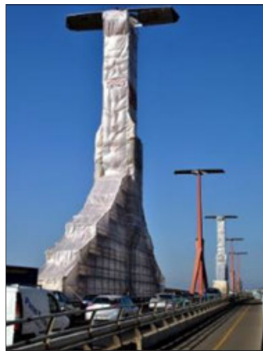
A lágymányosi Rákóczi híd pilonjainak korrózió elleni védelme
