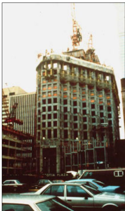
Fig. 2: Nagy hatékonyságú vízigény csökkentő adalékszerek (HRWRAs) felhasználásával készített magasépületek: (a) Scotia Plaza építése (photo courtesy of John Bickley); (b) Two Union Square építése (photo courtesy of Weston Hester); és (c) Petronas Towers (photo courtesy of Morio and Wikimedia Commons)
