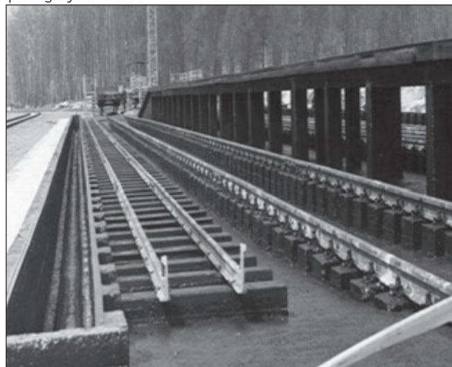
15. ábra: IKR Iparszerű Kukoricatermelési Rendszer folyékony műtrágya gyárának Epofur bevonatos vasbeton vasúti anyagfogadó és teherkocsimosó iparvágánya
