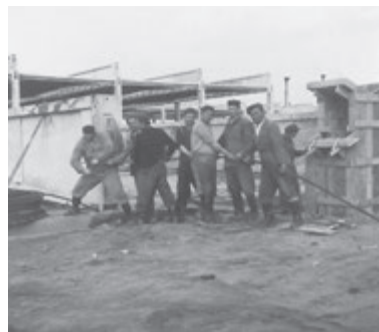
Hódmezővásárhelyi szaniterárú gyár utófeszített főtartói - feszítő huzalok betolása
