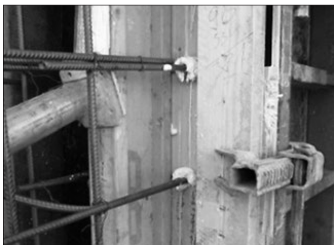
15. ábra: Zsaluzat betonozás előtt: munkahézagok tömítése
