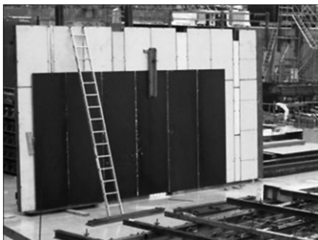
13. ábra: Zsaluzat beépítés előtt: látvány héjelemek felszerelése
