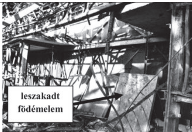
12. ábra: Stabilitásvesztéssel tönkrement vasbeton falpanel (bal oldali kép) és lemez (jobb oldali kép) (Testnevelési Egyetem tüzesete, 2015. okt. 15.)
