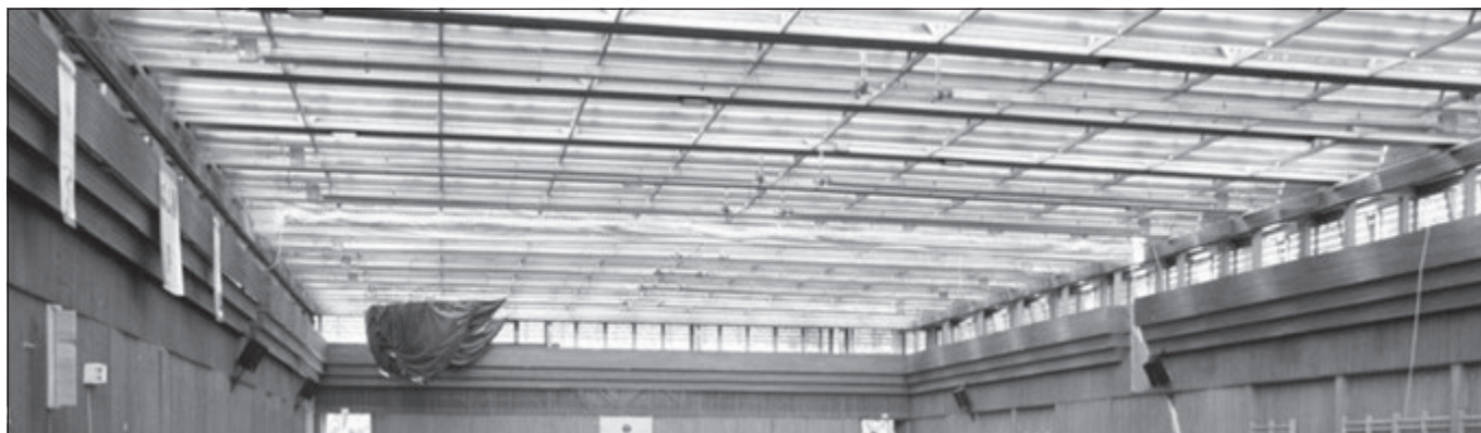
5. ábra: A leégett atlétikai csarnok tetőszerkezete és fa burkolata (tf.hu, 2011)
