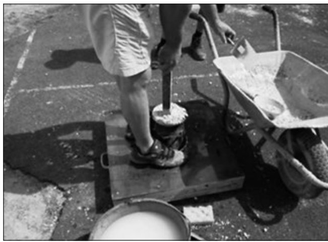
11. ábra: Terület mérés: a beton csömöszölése/tömörítése
