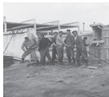
Hódmezővásárhelyi szaniterárú gyár utófeszített főtartói - feszítő huzalok betolása
