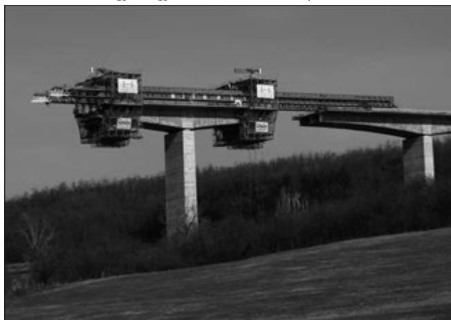
6. ábra: Kőröshegyi völgyhíd felszerkezetének építése
