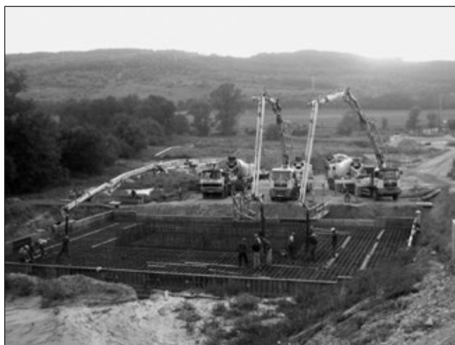
5. ábra: 1600 m 3 -es cölöpösszefogó gerenda építése
