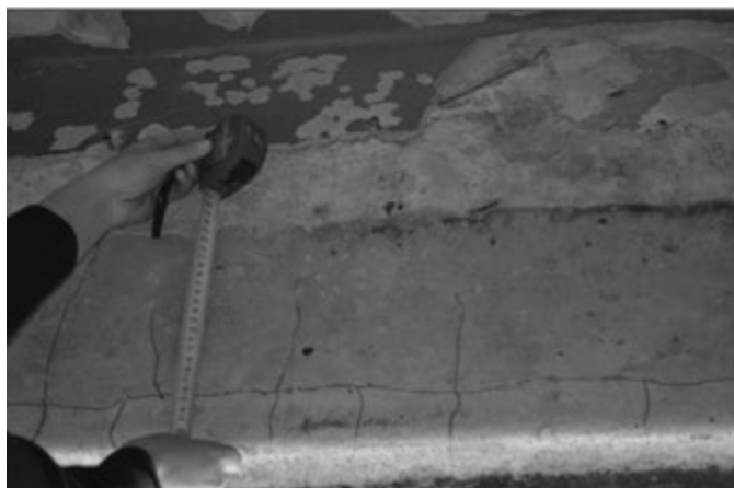
12. ábra: Az ablak fölötti áthidaló repedései
