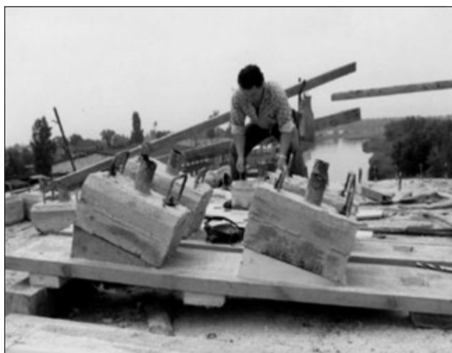
2. ábra: A feszítés lehorgonyzásaiba beépített előregyártott tömbök
