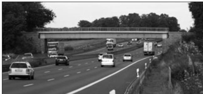
2. ábra: A világ első feszített betonhídja az A2-es autópályán (© Elke Wetzig (CC-BY-SA))
