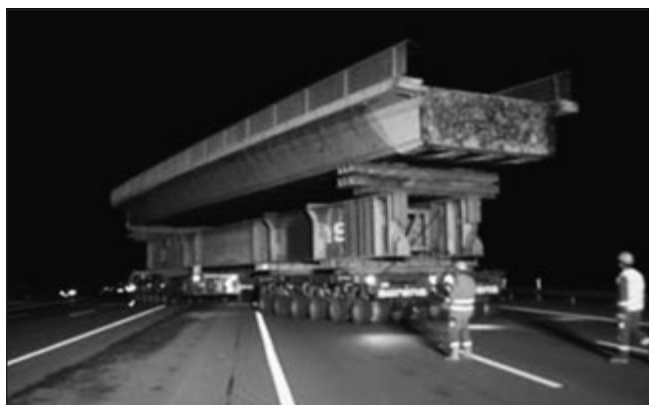
3. ábra: A Beckumi Hesseler-műemlék-híd áttelepítése (© www.eautobahn.de)
