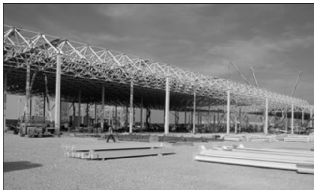
9. ábra: A térbeli rácsos szerkezet szerelés közben
