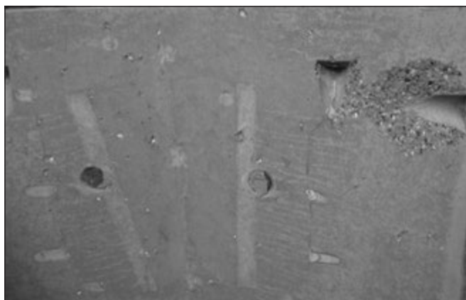
2. ábra: Mintavételi helyek tűzkárosult szerkezeten (fénykép, Balázs Lublóy, Földes, 2015)
