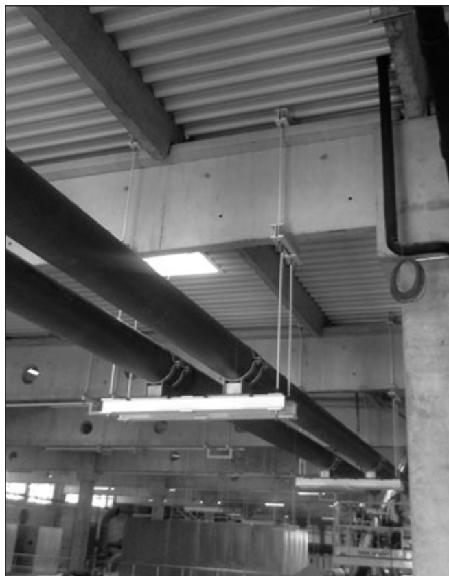
15. ábra: Gépészeti csövek felfüggesztése előregyártott feszített tartóra
