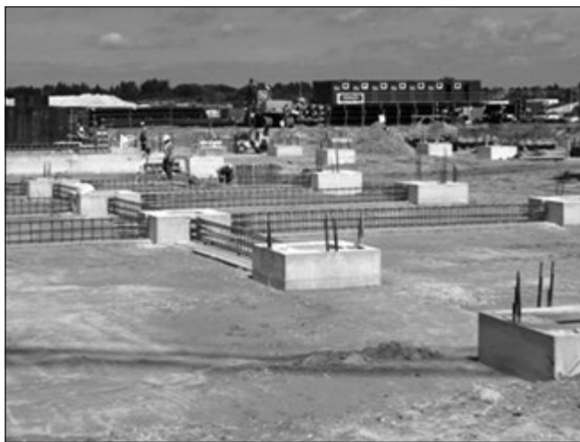
6. ábra: Elkészült kehelynyakak és az összekötő talpgerendák vasalása
