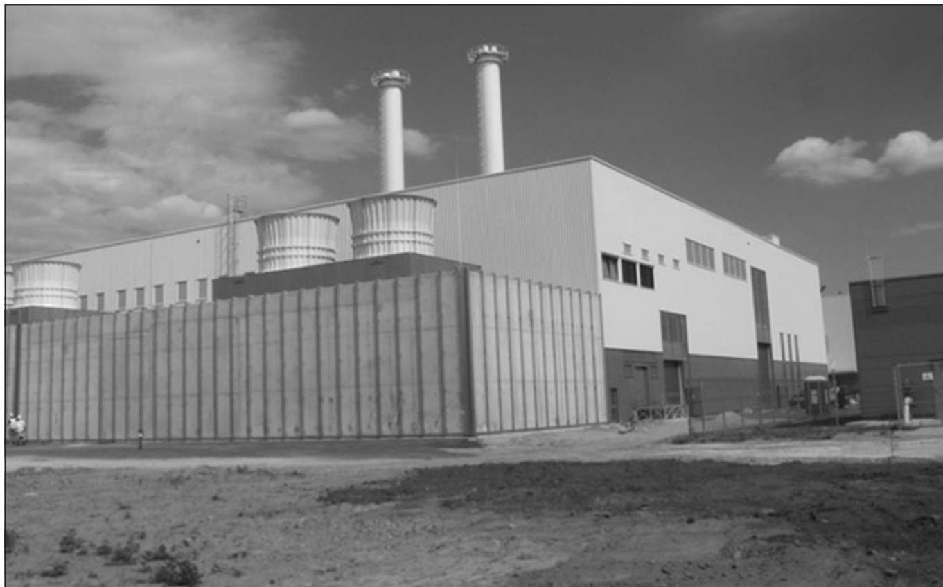
2. ábra: Vízvározó központ a csarnok mögött, északi és nyugati homlokzat
