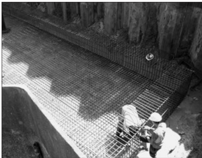
7. ábra: Lesüllyesztett fogadóakna alaplemezeinek vasalása szádfallal védett árokban
