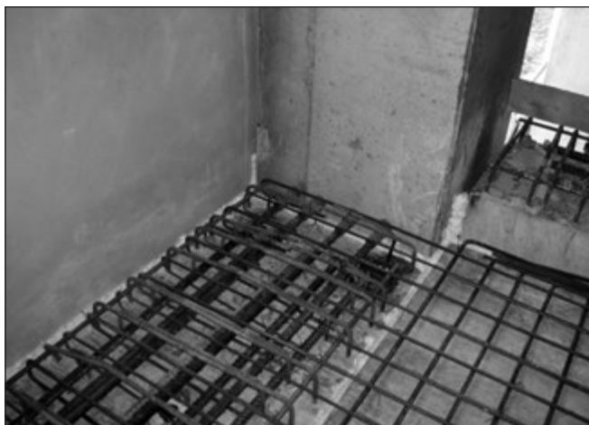
17. ábra: Előregyártott oszlop és monolit felbeton összeépítése
