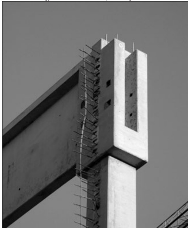
10. ábra: Előregyártott vasbeton oszlop villás fejkialakítása
