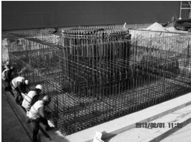
19. ábra: Kémény tömbalapjának vasszerelése
