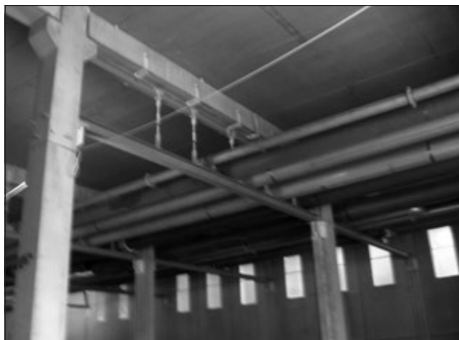
11. ábra: Gépészeti csövek utólagos felfüggesztése vasbeton gerendára
