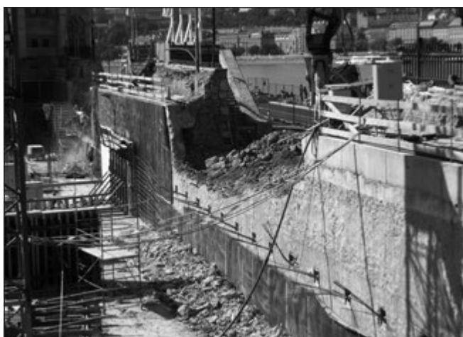
9. ábra: Résfall és felső támfal bontása látogató központi és mélygarázs bejáratnál 2013.09.05-én
