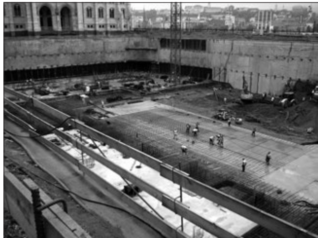
6. ábra: Alaplemez készültsége elárasztás előtt, Balassi Bálint utca felől 2013.05.30-án
