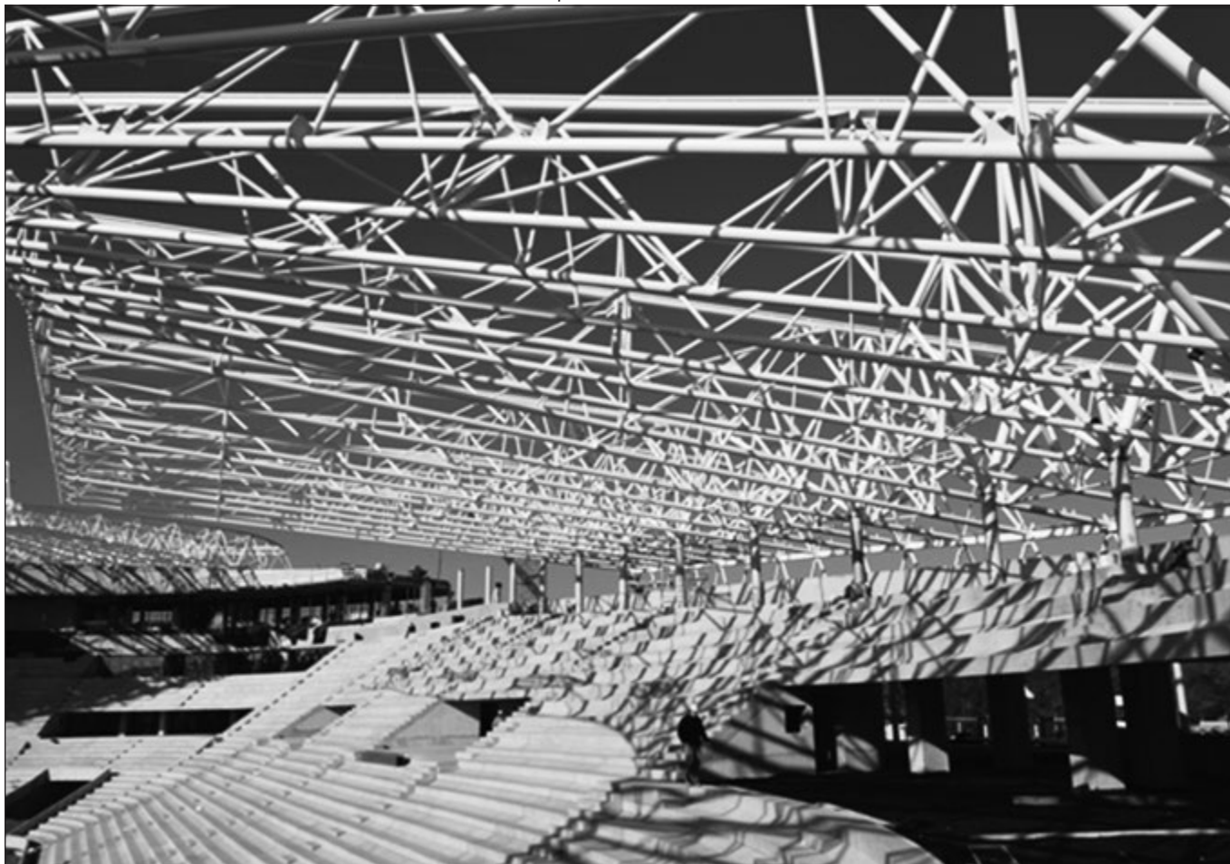
14. ábra: Rövidebb oldalak „átmeneti” tetőszerkezete szerelési állapotban
