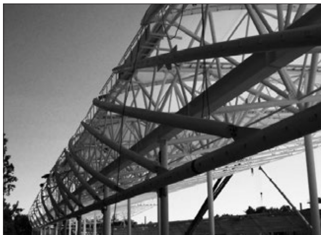
13. ábra: Homlokzati csőívek a tetőszerkezettel
