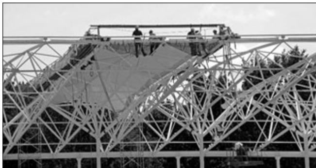
12. ábra: Membrán héjazat szerelése
