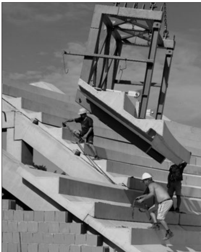
6. ábra: Alul sík előregyártott lelátóelemek
