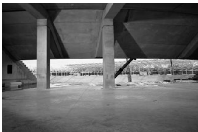
8. ábra: Alul „sík” íves előregyártott lelátóelemek
