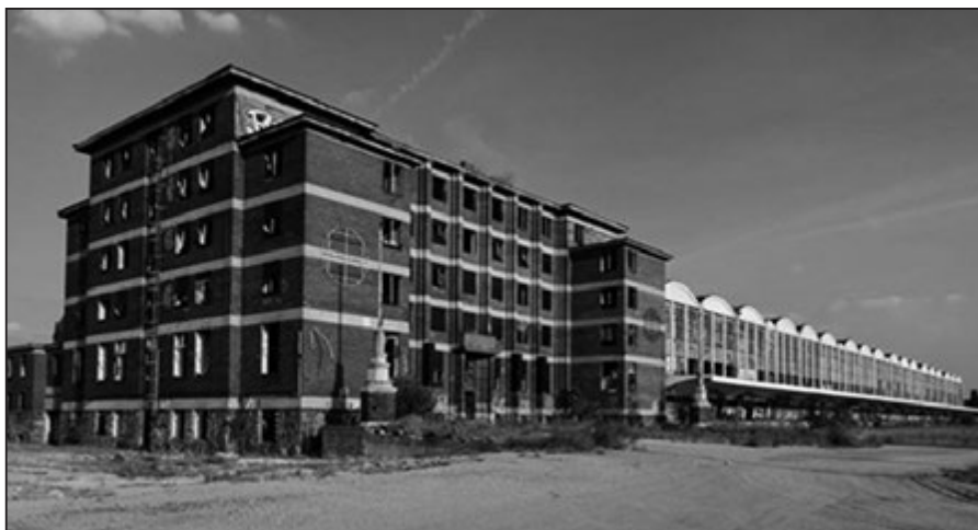
4. ábra: A budapesti nagyvásárcsarnok
