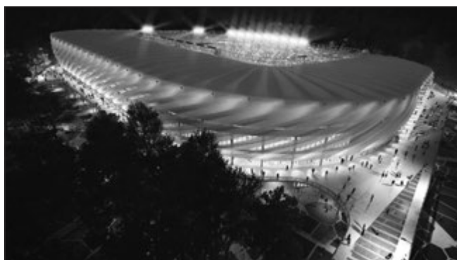
3. ábra: Nagyerdei Stadion a levegőben vezetett járdával
