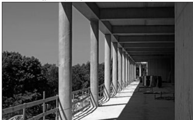
5. ábra: Előregyártott pillér-gerenda váz, takart csomópontokkal
