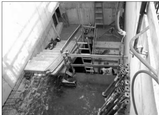
13. ábra: Beépített és elhelyezett előregyártott lépcsőkarok 2013.09.19-én
