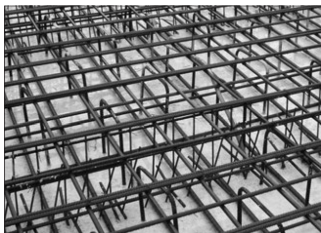
15. ábra: Fehércementes látszóbetonnal kiöntött kéregbeton és a keresztmetszet együldolgoztatására általános szakaszon alkalmazott sűrített távtartó vasalás 2013.11.05-én
