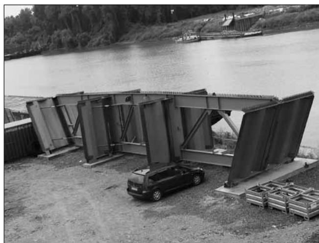
7. ábra: Beemelésre váró acélszerkezet
