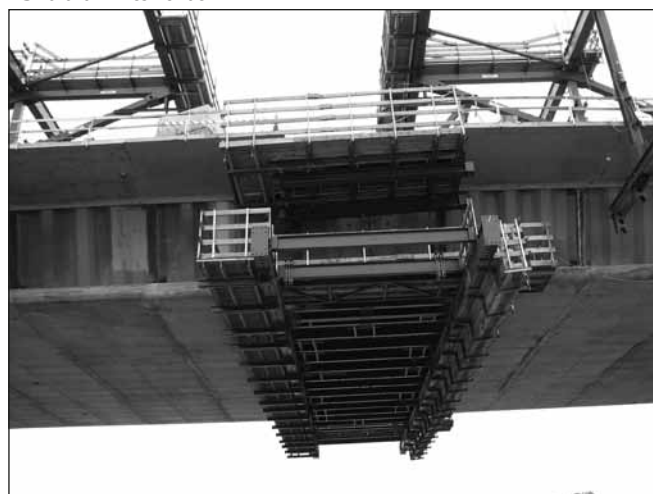
16. ábra: Mederzárás a pilonról szemlélve
