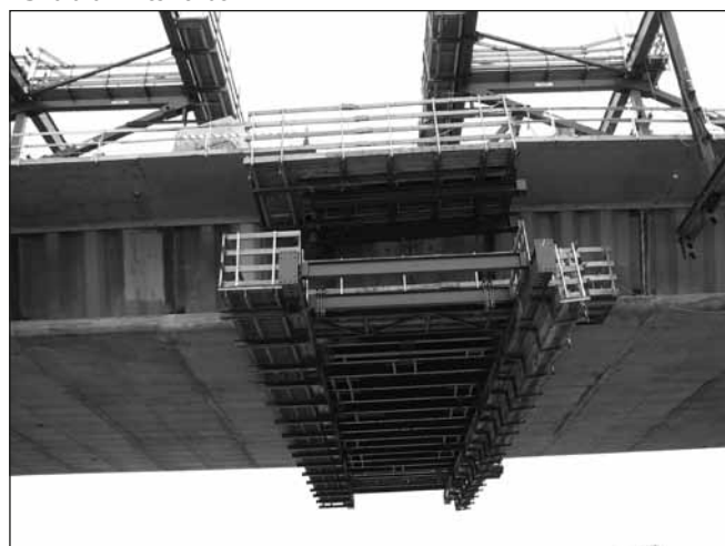
16. ábra: Mederzárás a pilonról szemlélve
