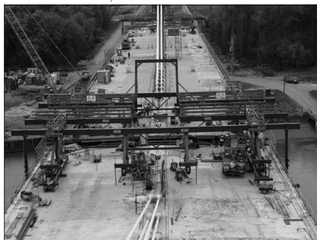
16. ábra: Mederzárás a pilonról szemlélve
