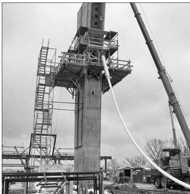
10. ábra: Kábelbefűzés
