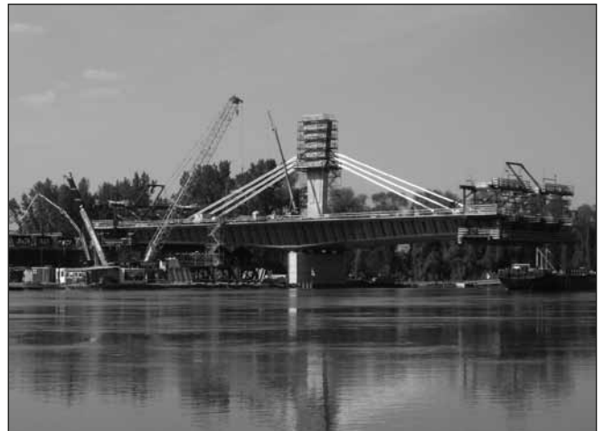
3. ábra: Mederhíd szabadszerelése
