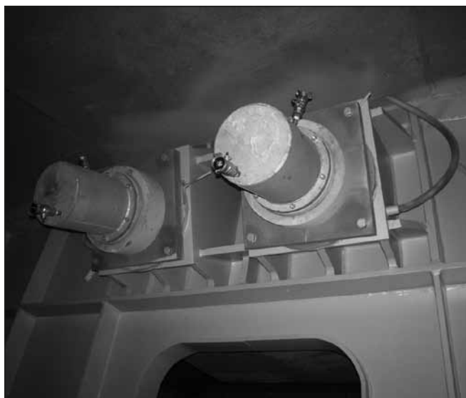
6. ábra: A ferdekábel lehorgonyozása
