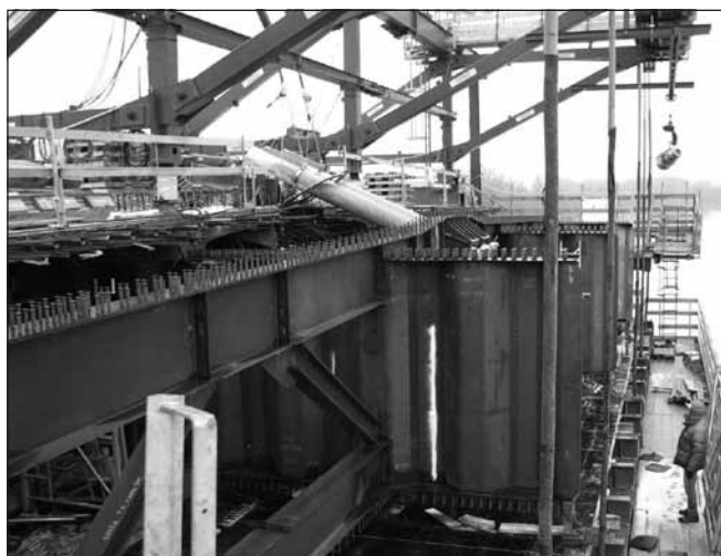
5. ábra: A keresztmetszet acélváza
