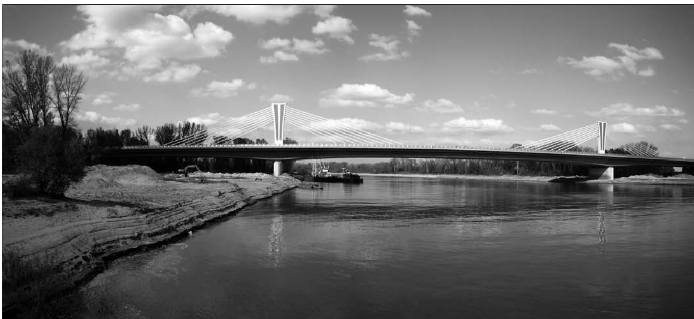
1. ábra: A Móra Ferenc-híd a Tisza felől
