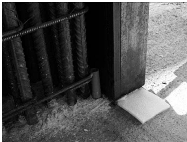
9. ábra: Polifoam csík a zsaluzat alatt
