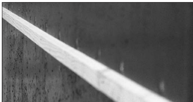
11. ábra: Munkahézag kialakítása
