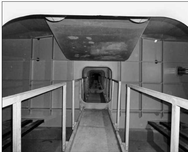
5. ábra: A ferde kábelek lehorgonyozása
