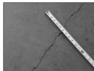
18.a,b ábrák: NY Post Nyomda Épület beton földem, New York, NY Repedés jele
