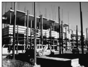
15. ábra: L’Ambiance Plaza, Bridgeport, Conn. Teljes összeomlás
