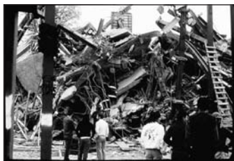
15. ábra: L’Ambiance Plaza, Bridgeport, Conn. Teljes összeomlás
