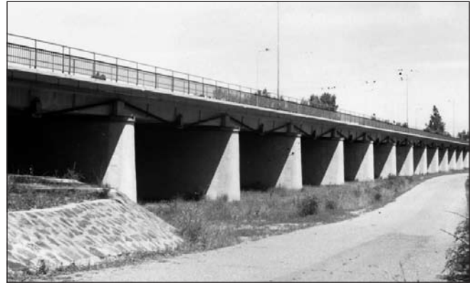
2. ábra: A szolnoki ártéri „százlábú” Tisza-híd
