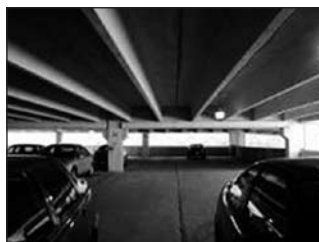
19.a,b ábrák: Parkoló épület, Holyoke, Mass. Túlzott deformáció (lehajlás)
