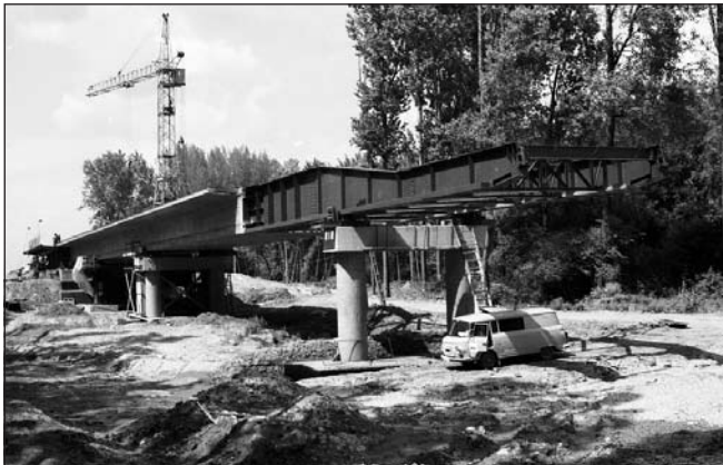
1. ábra: A cigándi Tisza-híd betolás közben
