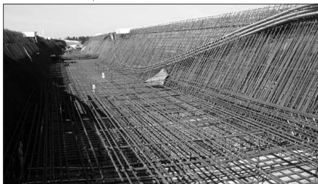
17. ábra: A Kytömaa csomóponti teknőhíd vasbetétei és feszítőelemei, © R. Kanervo, YIT Corp.
