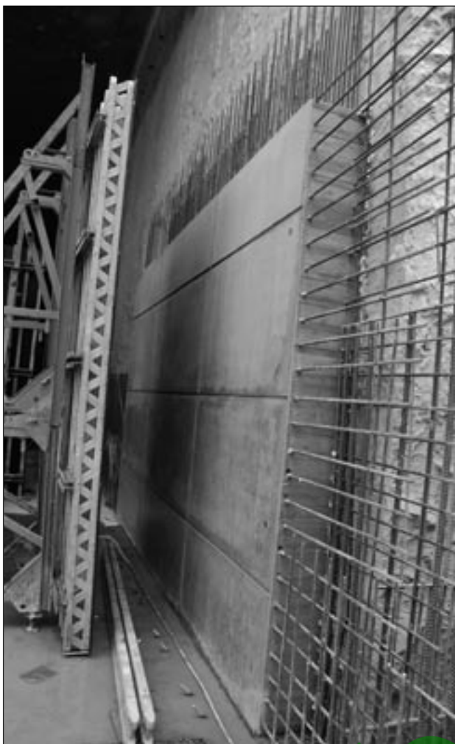
4. ábra: Látszó-betonfelület kivitelezése
