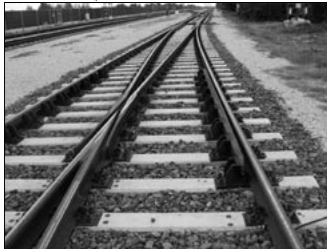
2. ábra: Vasbetonalkakra fektetett kiterő a MÁV vonalán
