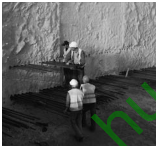
3. ábra: Résfal-alaplemez kapcsolata lentonok alkalmazásával
