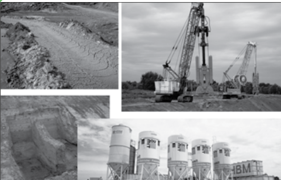
7. ábra: A résfal építése
