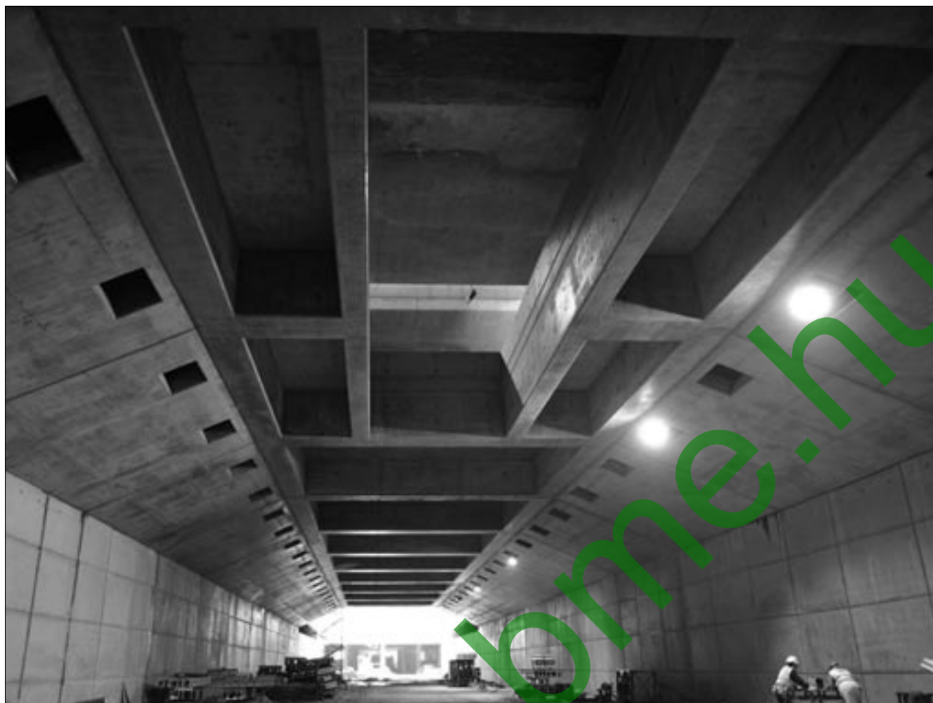
10. ábra: Alulbordás vasbeton födém
