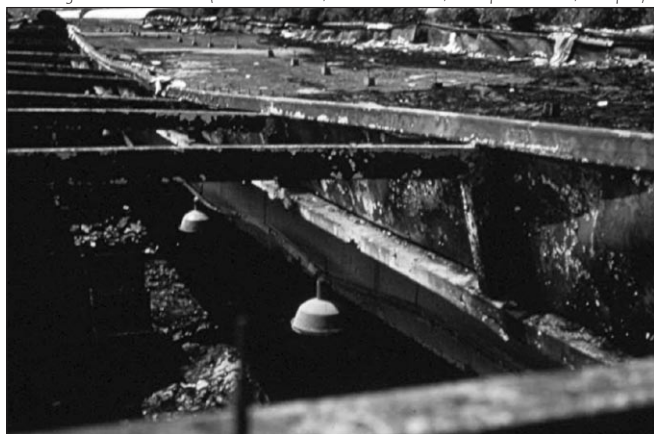
1. ábra: Feszített vasbetongerendák több deciméter nagyságrendű maradó lehajlást szenvedtek (feszítáv 18 m, tűzeset 1985, Masped raktár, Csepel)
