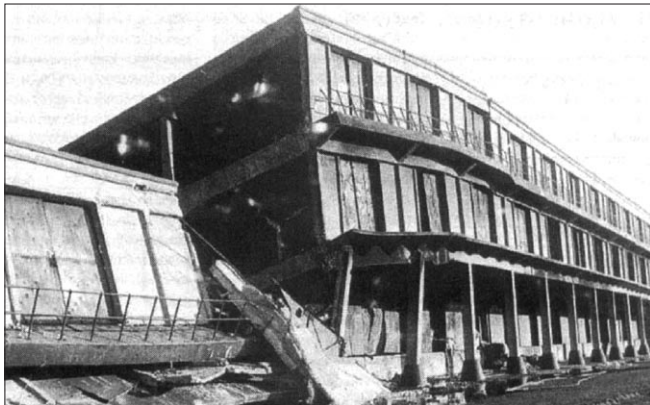
b) A genti áruház összeomlása tűz hatására, (fib, 2008)
