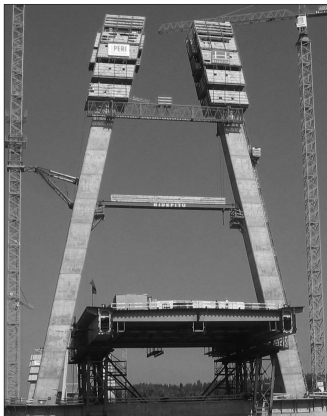
3. ábra: Merevítőtartó szereléskezdés indítóállványról
