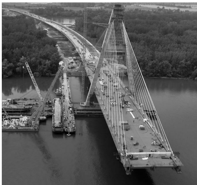
5. ábra: Szentendrei sziget oldali fél híd, konzolhossz = 133 m
