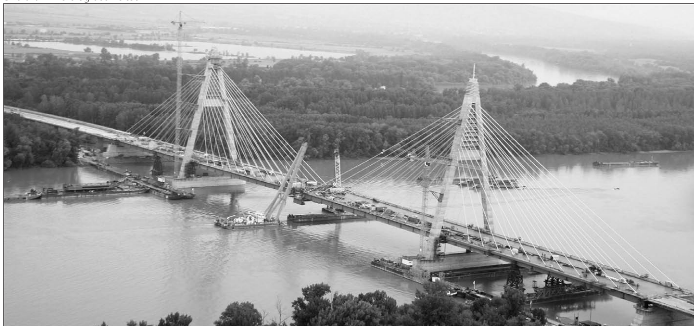
6. ábra: A zárótag beemelése
