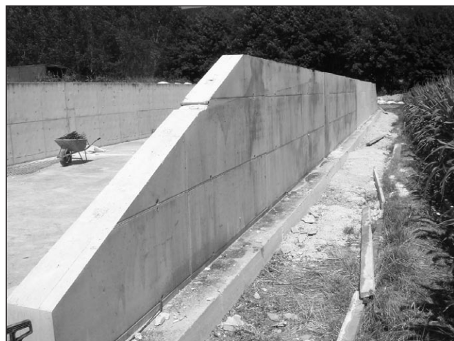
9. ábra: Lapos siló az alsó-ausztriai Markt Piestingben nagyszilárdos betonból készült falazattal
