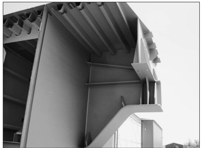
6. ábra: Pilonkereszttartó támaszkonzol
