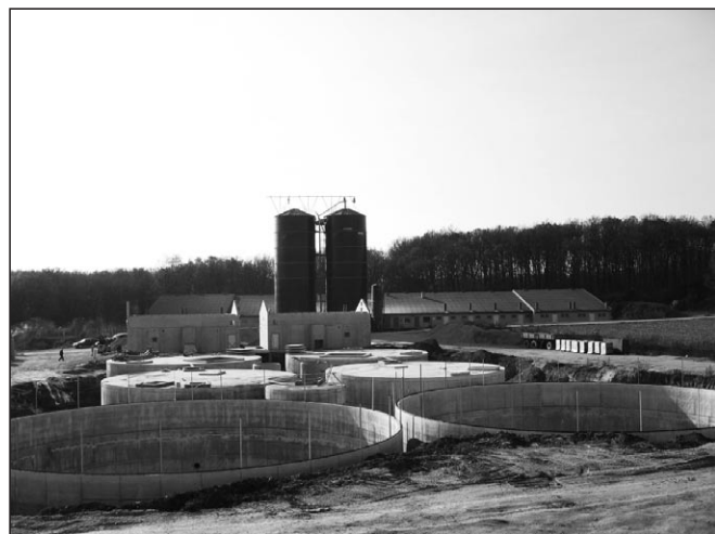
8. ábra: Biogázberendezés a burgenlandi Pöttelsdorfbán
