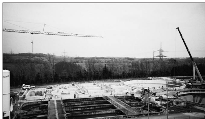
7. ábra: Oberwarti derítő – háttérben a Slagstar® betonból épült új rész
