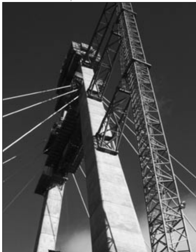
8. ábra: Daru kikötése a pilonszárhoz
