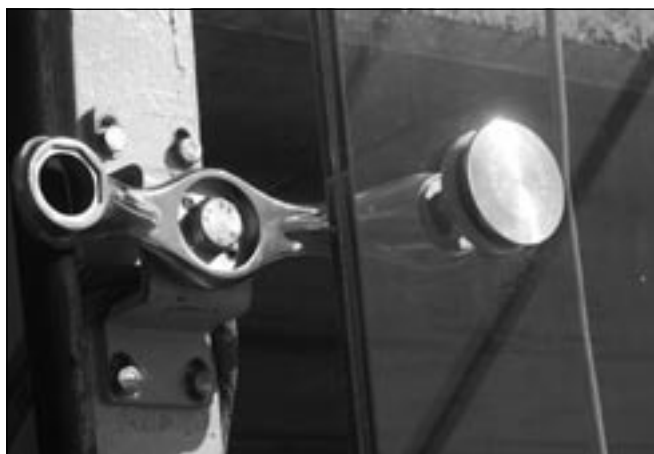
11. ábra: Üvegfal pontmegfogásos részlete
