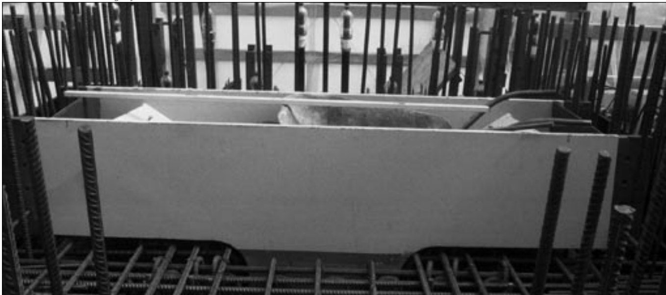
6. ábra: Ferdekábel lehorgonyzó acélelem
