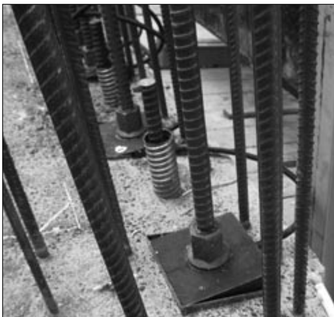
5. ábra: A \varnothing 40 feszítőrúdak lehorgonyozása munkahézagnál
