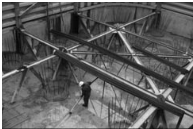
3. ábra: Cölöpfejek vasalása a vízalatti betonozás felett
