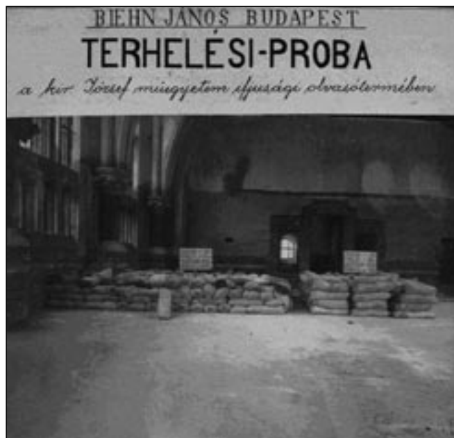
7. ábra: Központi Könyvtár Nagyolvasó födém próbaterhelése (Fővárosi Levéltár)
