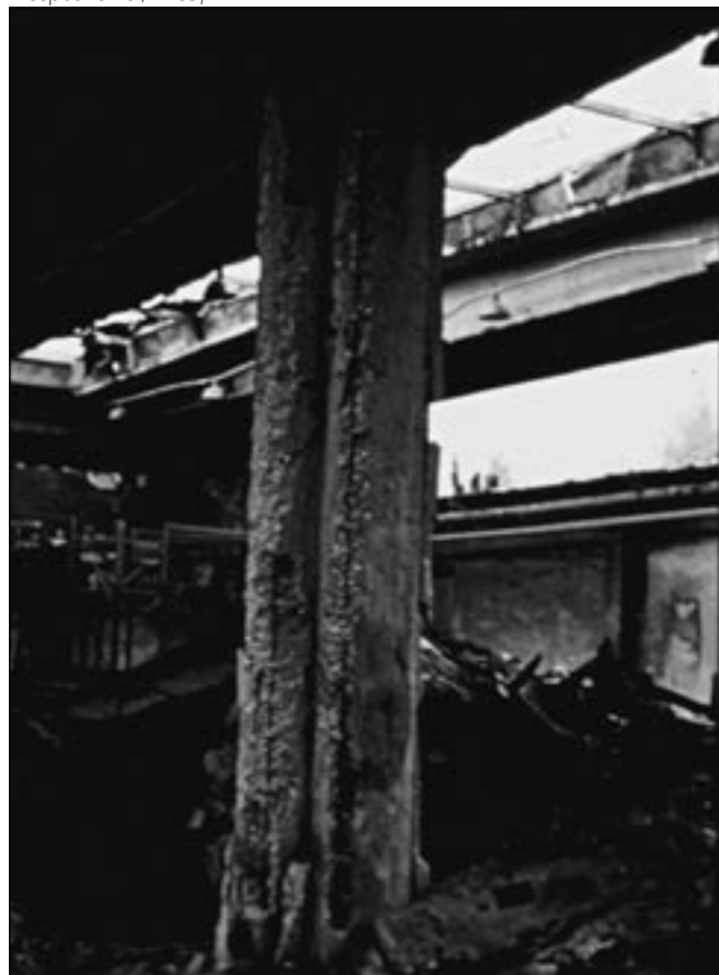
1. ábra: Vasbeton oszlop egy raktárban történt tüzeset után (Csepel, Masped raktár, 1985)
