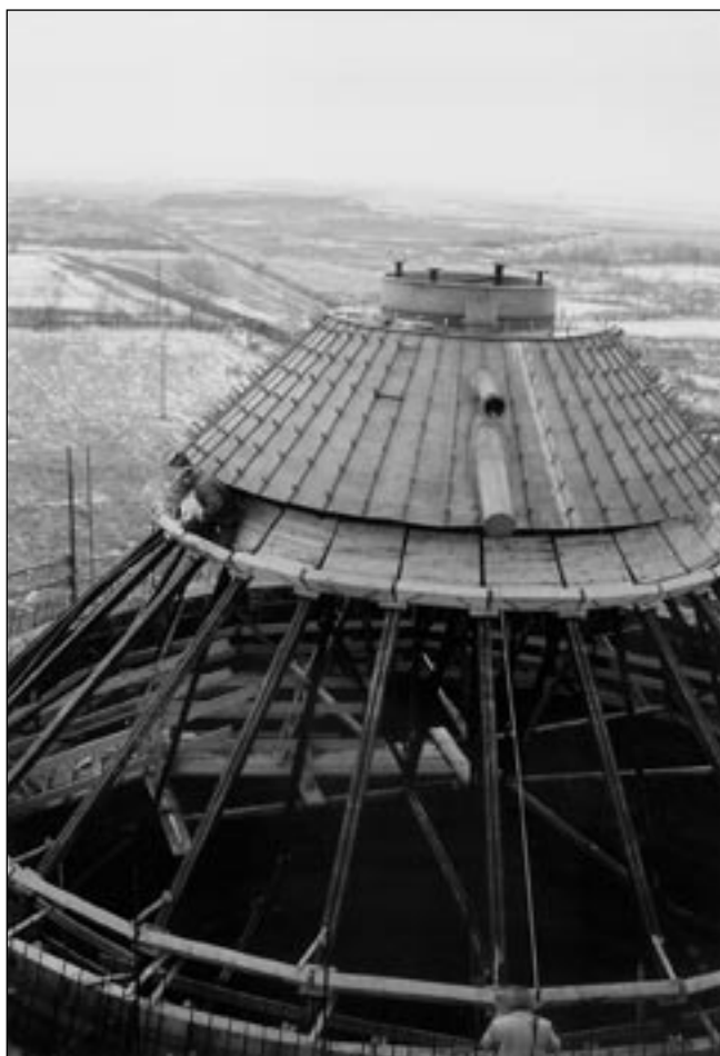
15. ábra: A felső kúp építés közben
