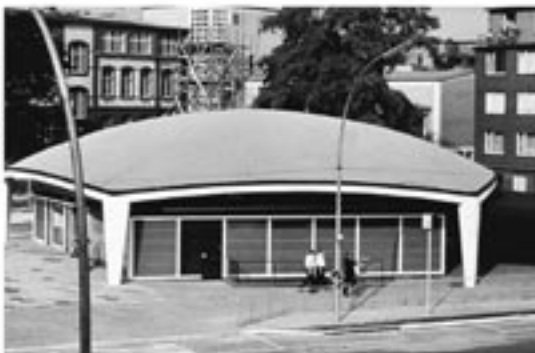
A hamburgi Lübecker-Strasse metróállomás, Építésszek: Sandmann & Grundmann
