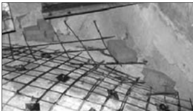
21. ábra: Betonháj vasszerelése a kíresztésekkel
