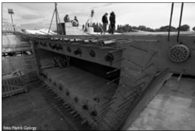
3. ábra: Építési egység keresztmetszete
