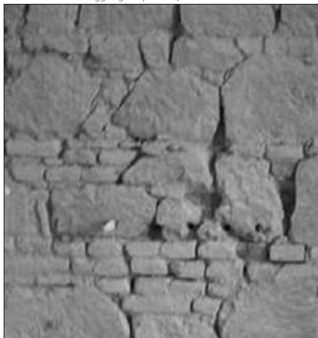
3. ábra: Előtéri fal függőleges repedésképe
