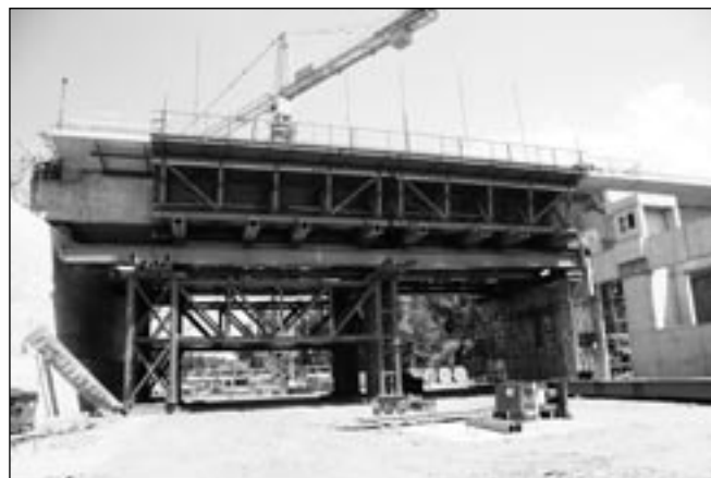
5. ábra: Gyártópad a 19. és 20. jelű pillérek között
