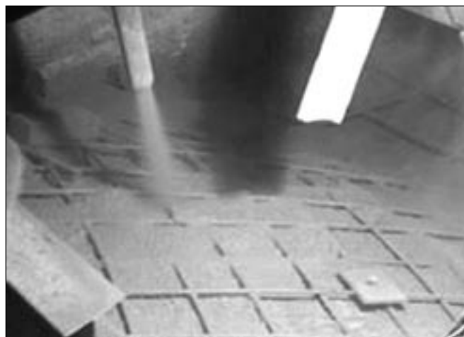
22. ábra: Betonhéj lőtt betonozása
