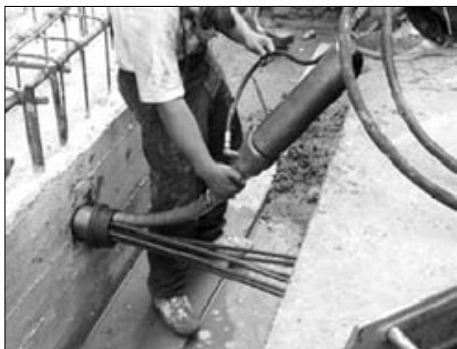
12. ábra: Kábelfeszítés
