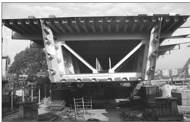
5. ábra: Csepelen összeállított keresztmetszet (készítette: Fornay Csaba)
