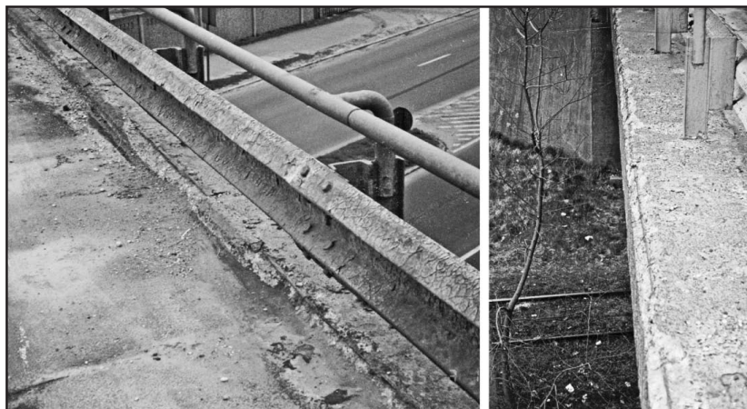
3. ábra: Hídsegélyek réteges felfagyása (Magyar Közút Kht. Győri Minőségvizsgáló Laboratóriumának fényképei)
