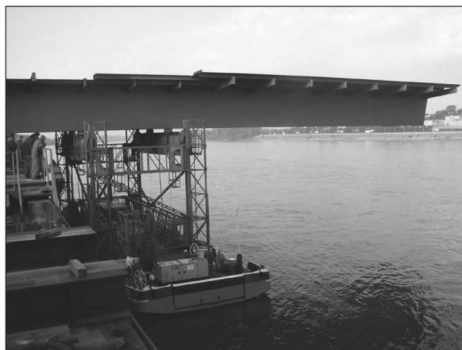
18. ábra: Behajózás Csepelen, az úszó- emelőmű átvieszi a terhet (készítette: Fornay Csaba)
