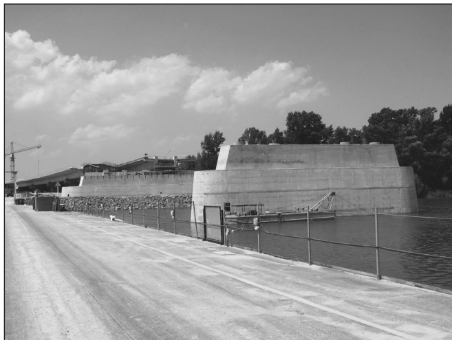
3. ábra: Vasbeton meder- és parti pillér (készítette: Fornay Csaba)
