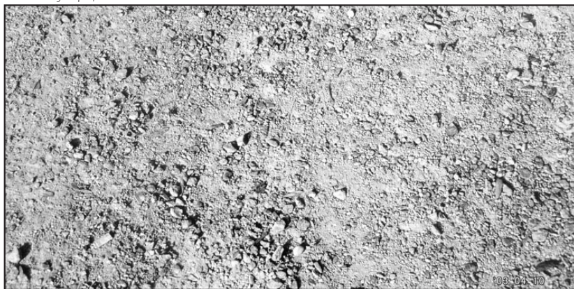
2. ábra: Kis forgalmi terhelésű útburkolat fagykárosodott felülete (Kausay Tibor fényképe)
