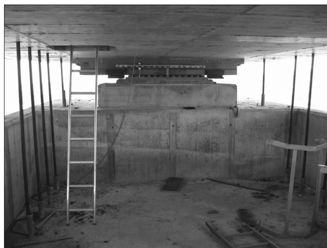
4. ábra: Az indítózöm leköttése feszítő rudakkal
