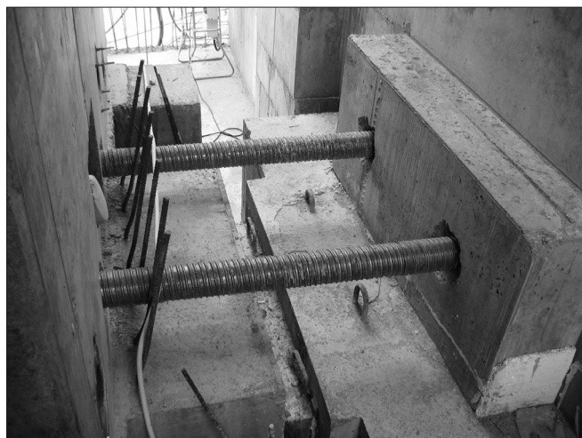
6. ábra: A kikötő kábelek átvezetése a hídfő és a felszerkezet között
