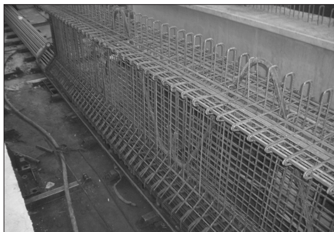
6. ábra: Az FI-150 gerenda betonacél váza végén lévő két emelőkampóval
