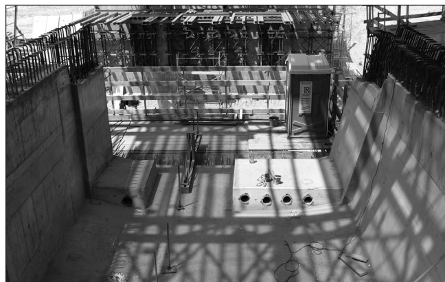
9. ábra: Alsó záró kábelek lehorgonyzásai
