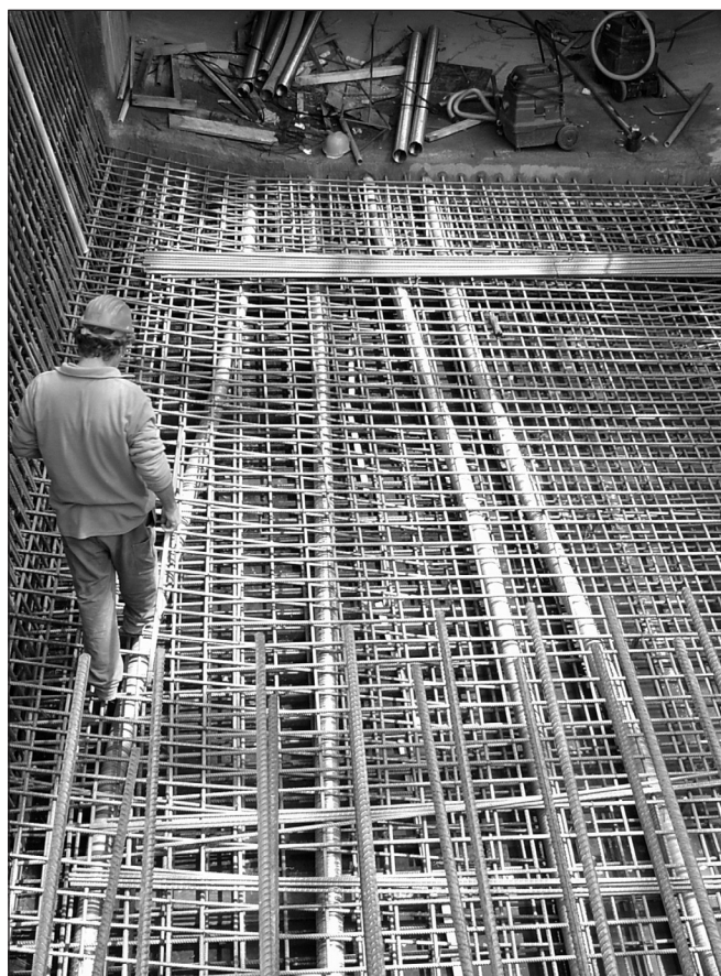
8. ábra: Záró kábelek az alsó lemezben
