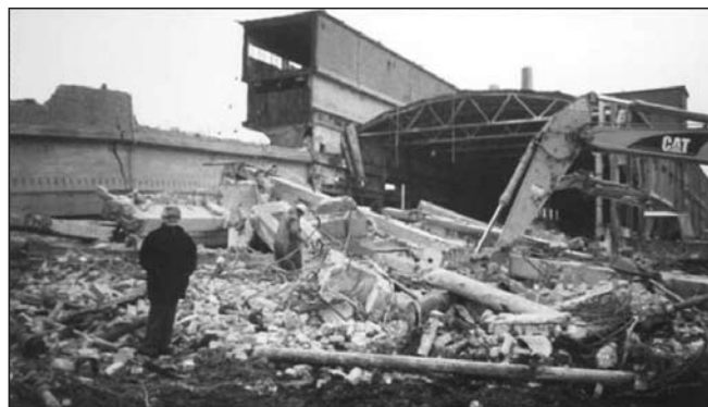
2. ábra: A felrobbantott csarnok
