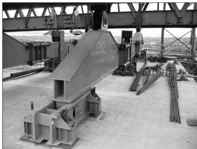
8. ábra: Emelőhimba rögzítése a zömhöz DYWIDAG-rudakkal
