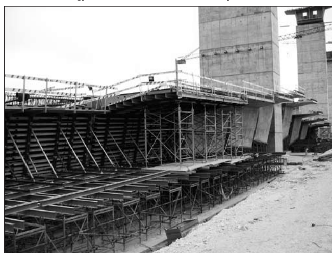
11. ábra: Előregyártott zömök alátámasztó állványzattal és zsaluzattal
