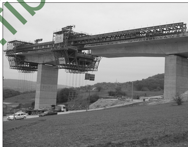
2. ábra: A segédhíd építés közben
