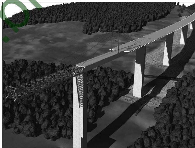
3. ábra: Az acélszerkezet betolása (készült az engedélyezési tervhez)
