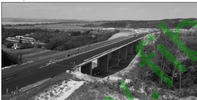
1. ábra: S16 elkészült híd
