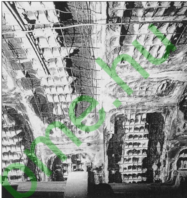
14. ábra: Betonfelület és felszínre került vasalás a Csatorna Alagútban kitört tűz után (Blennemann és Girnau, 2005)
