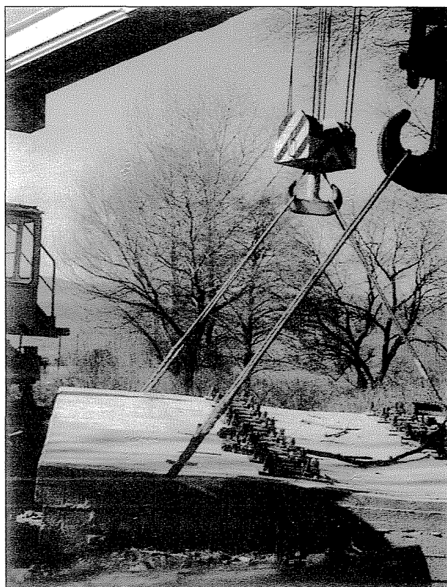
14. ábra: Közvetlen leerősítésű vasbeton lemezhid beemelése 1989-ből
