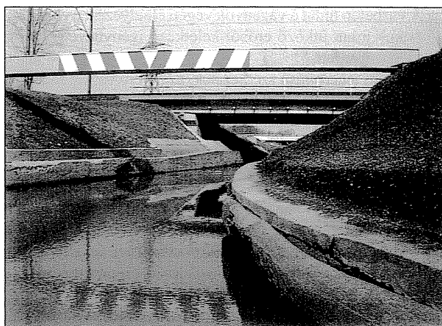
21. ábra: Védőkapuval védett patak-híd
