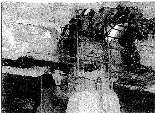
1. ábra: A merev betétes bauxitbeton szerkezet egyik kibontott csomópontja alulról
