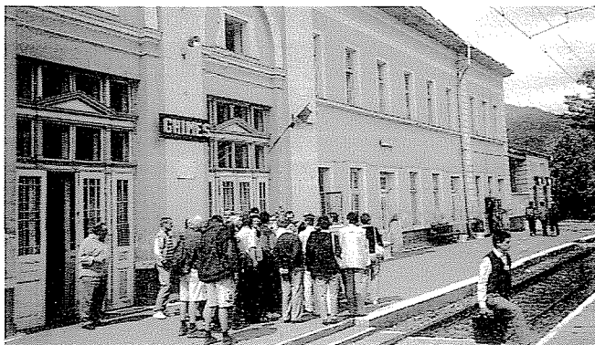
4. A gyimesi vasútállomás felvételi épülete
