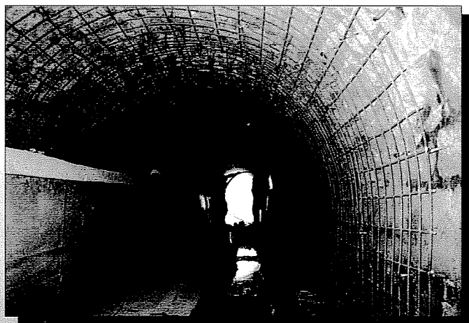
8. sz. főút Öskű római gáti boltozat erősítése
