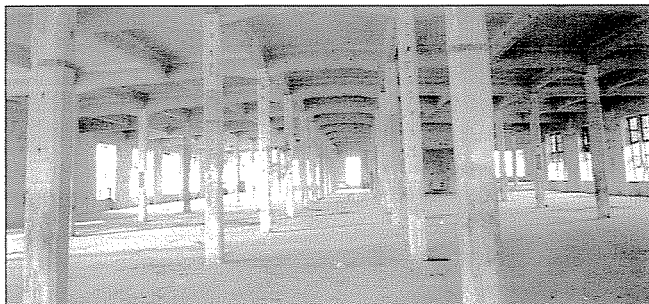
6. ábra: Az I. jelű épület 3. emeletének vázszerkezete az átalakítás és felújítás előtt
