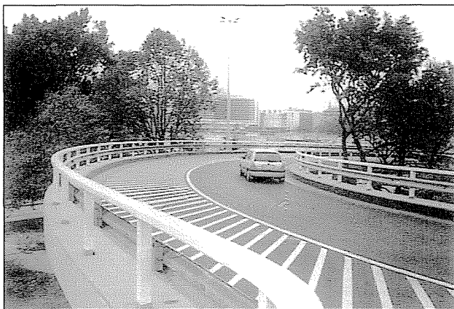
5. ábra: A felújított hídpálya
