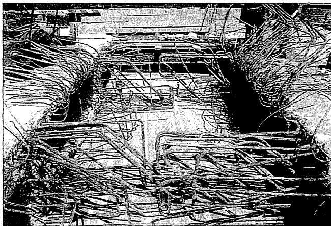
2. ábra: Kibontott Gerber-csukló
