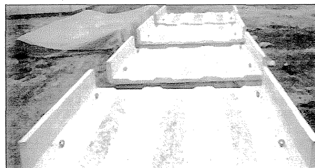
8. ábra Feszítettbeton szalaghíd bennmaradó zsáladóelemei (Tokyo Rope, 1993)
