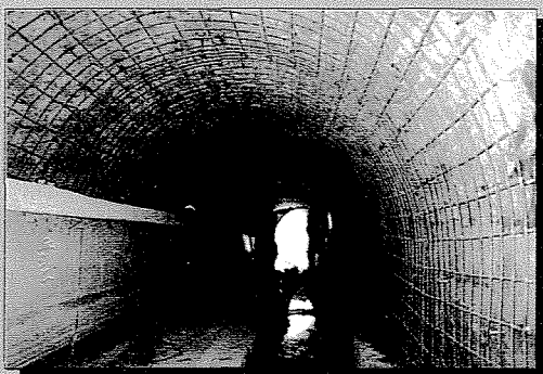
8.sz. főút Öskű római gáti boltozat erősítése
