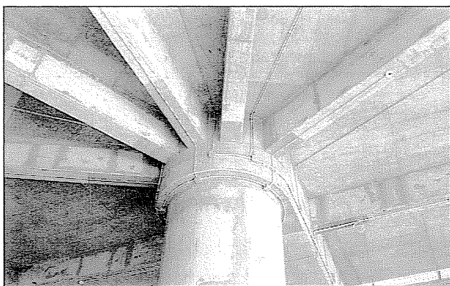
2. ábra A 2 m átmérőjű pilonhoz csatlakozó tartószerkezetek
