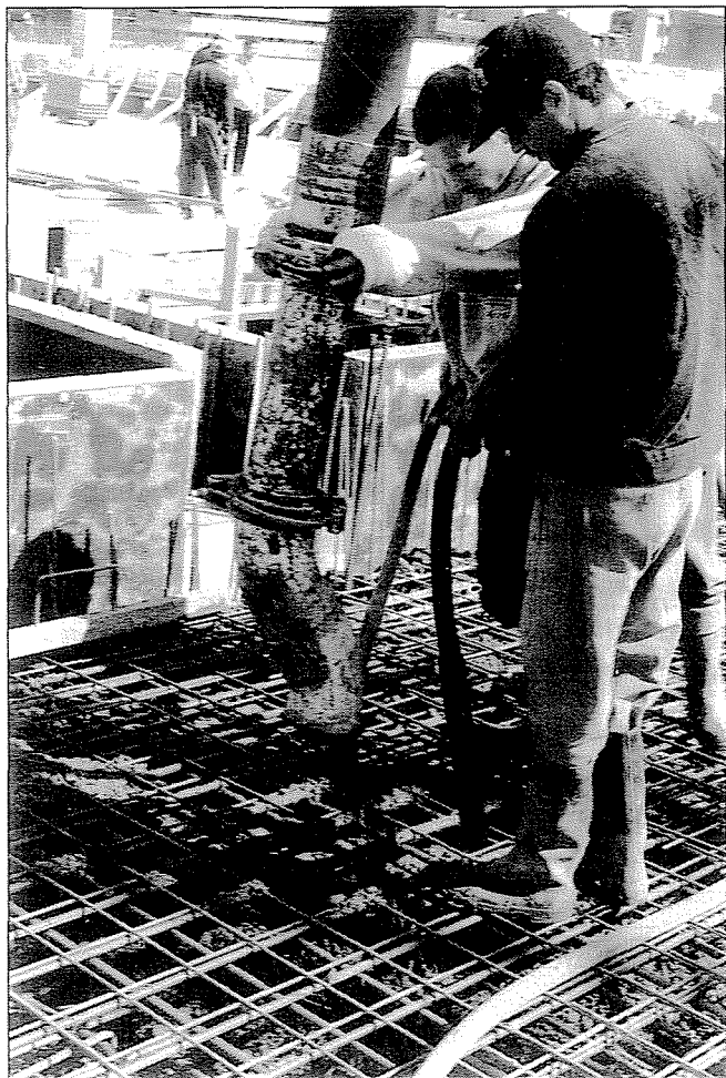
4. ábra: A vasalás sűrűsége
