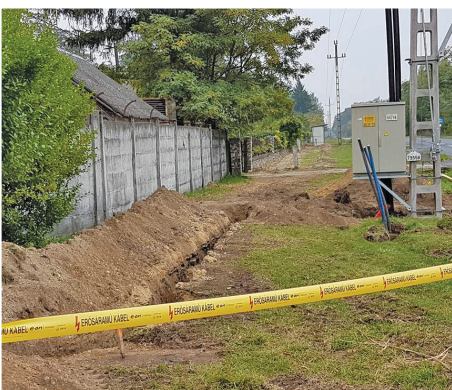
Megkezdődött a Meggyeserdő bal oldalán a villanyhálózat újraépítése.
