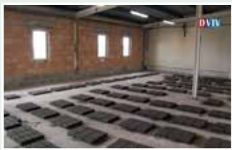
Átadásra került a betonelemgyártó csarnok.
