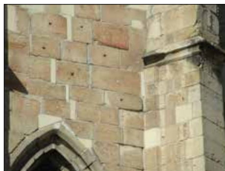
■ 4. kép: A fal síkjával párhuzamos rengés hatására egymástól eltávolodott kváderek közeit keskeny kőcsikkokkal töltötték ki a restaurálás során. A támpillérral szomszédos egyik tömb kismértékben elfordult: jobboldali széle néhány centiméterrel közelebb került a szemlélőhöz. © KÁZMÉR Miklós
