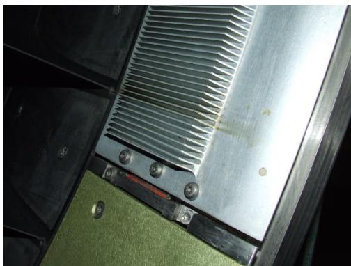
10. ábra Felületi hőcserélő a ventilátor kilépésénél (a szerző felvétele)
