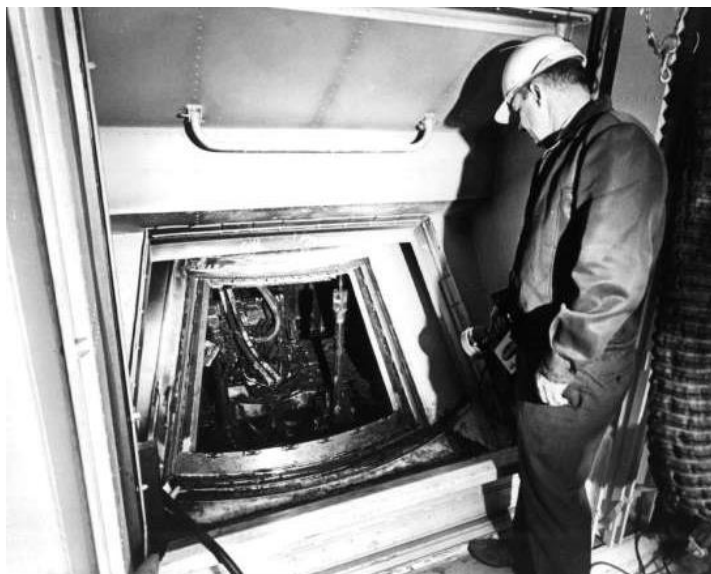
15. ábra A kiégett parancsnoki modul ajtaja a fehérszobából [31]
