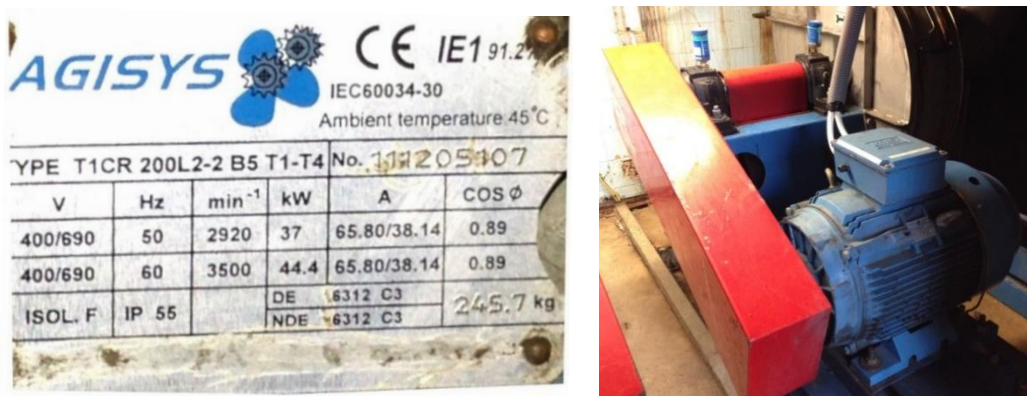
4. ábra Szén-dioxid szivattyú hajtómotorjának adatlapja és beépítési helye
