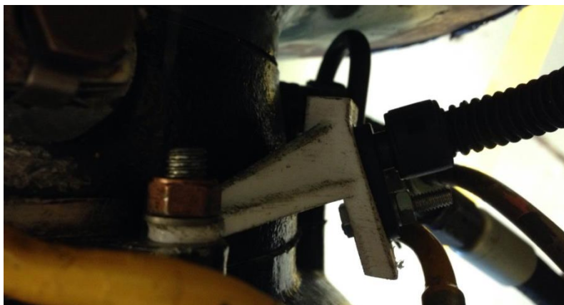
8. ábra A konzol beépítése
