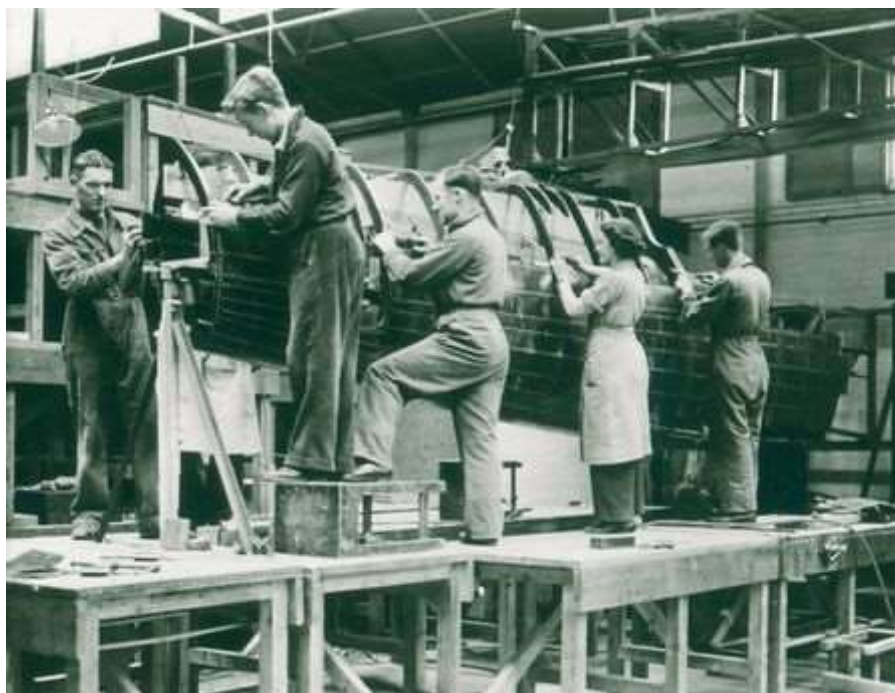
23. ábra Repülőgéptörzs építése 27
