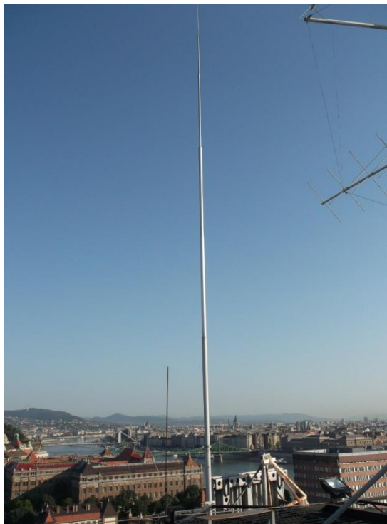
7. ábra A villámvédelmi levezető
