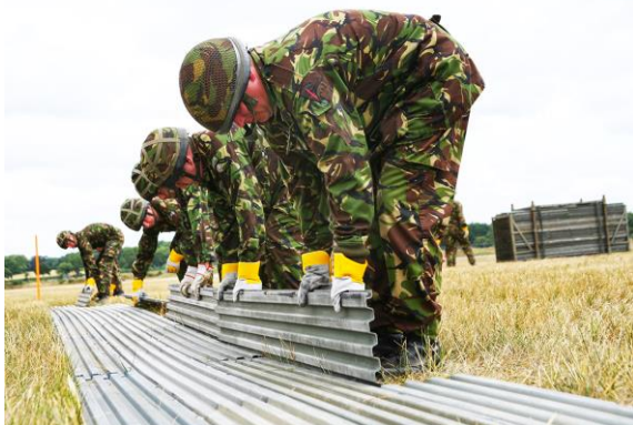
21. ábra A PSA elemek telepítése 49
